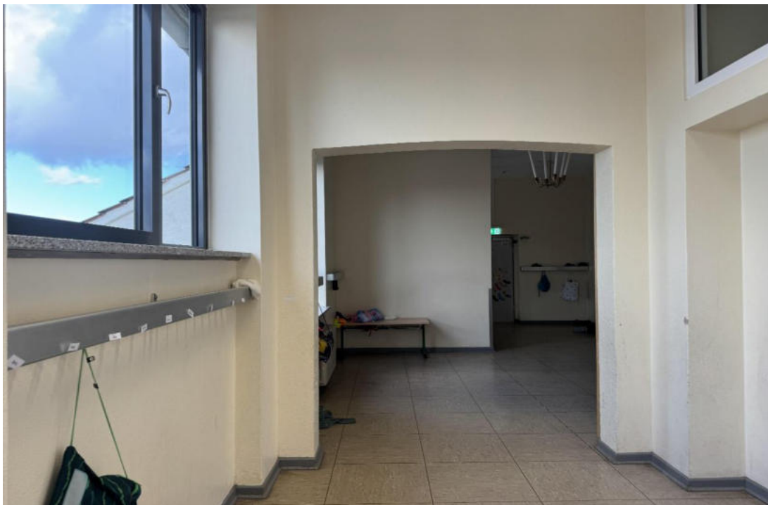
Bild 12 : Der Anstrich und der Putz der Massivwände im Erdgeschoss und 1. Obergeschoss sind gemäß den früheren Schadstoffuntersuchungsberichten (WESSLING GmbH, 05/2013) asbesthaltig .
