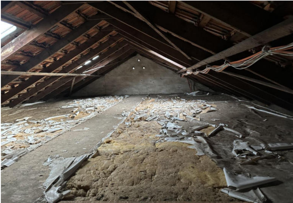
Bild 5: KMF-Isolierung im Boden und im Dachstuhl-optischer Befund
