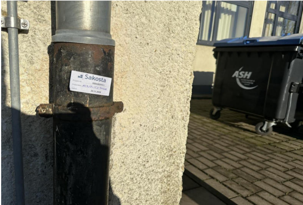
Bild 11 : Der schwarze Anstrich der Regenwasserleitung im Außenbereich (Nordseite) ist hoch PAK-belastet .
