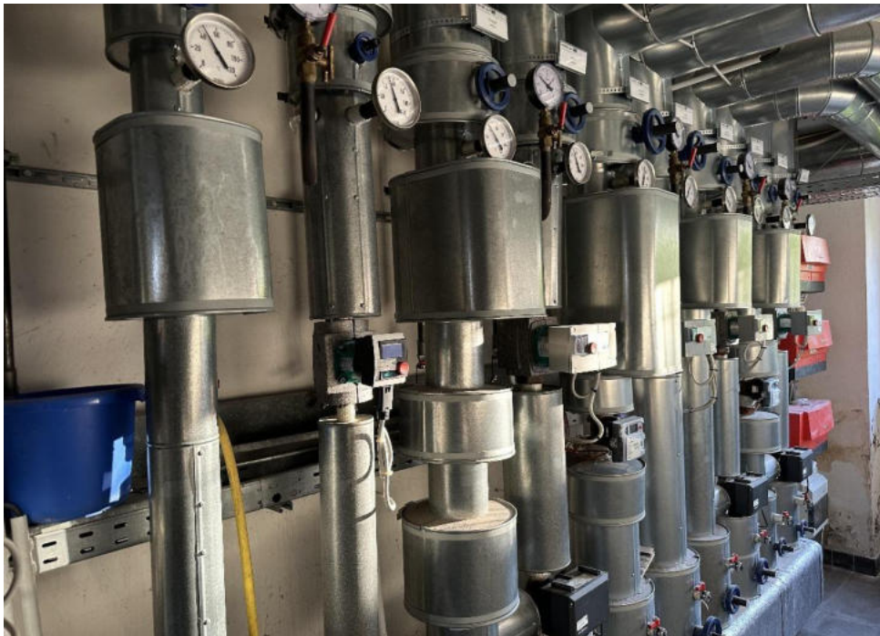
Bilder 4: Technische Anlagen – KMF-Isolierung im Kellergeschoss- optischer Befund
