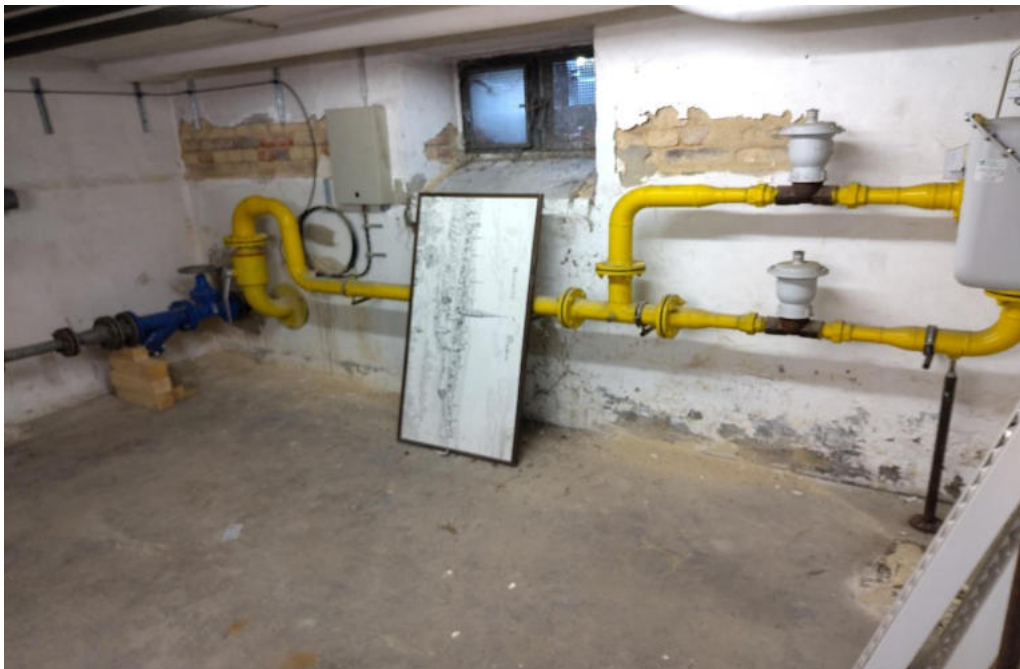
Bild 6: Dichtungen an den Flanschverbindungen der Technikanlage(Rohrleitungen in Kllergeschoss ist Asbesthaltig -optischer Befund.
