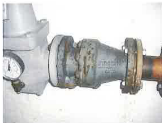
Foto 7: Schule, KG, K2, Flanschdichtungen (MP-57)
