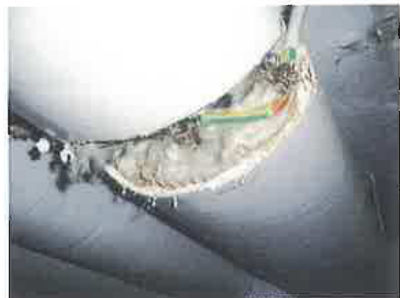
Foto 12: Schule, KG, K2, Rohrleitungen, Isolierung (MP-58)
