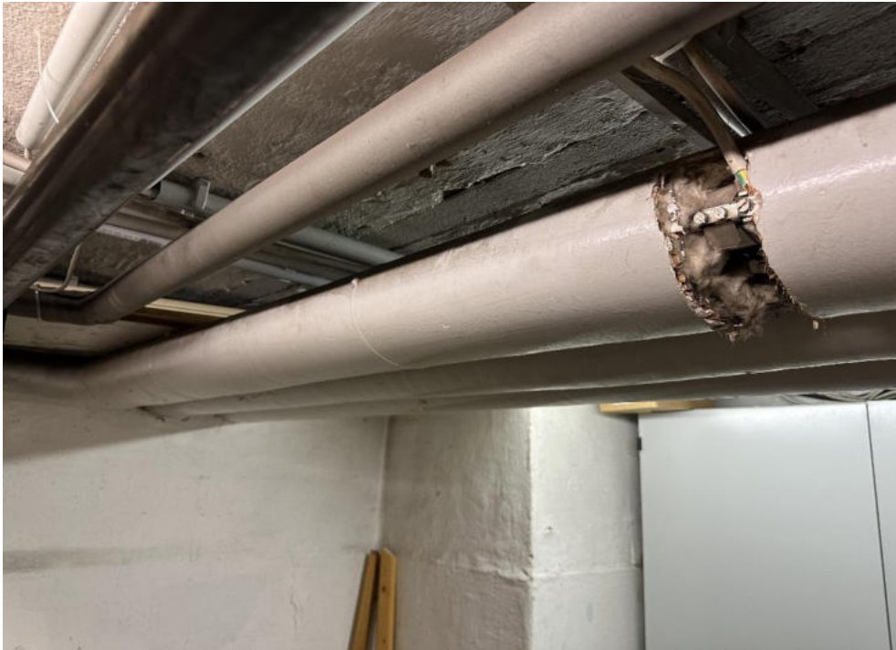
Bilder 3: KMF-Isolierungen an Rohrleitungen (Rohrummantelungen) im Kellergeschoss.- optischer Befund.
