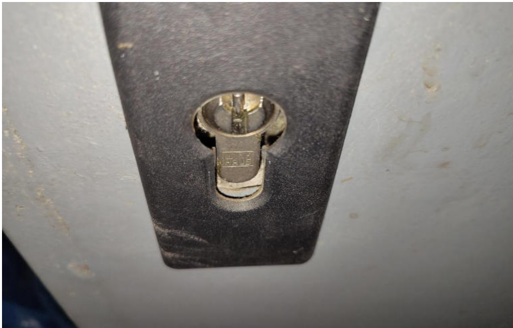
Bild 7 : Einlagen in Feuerschutztüren mit Baujahr vor 1993 im allen Geschossen sind asbesthaltig . - optischer Befund.
