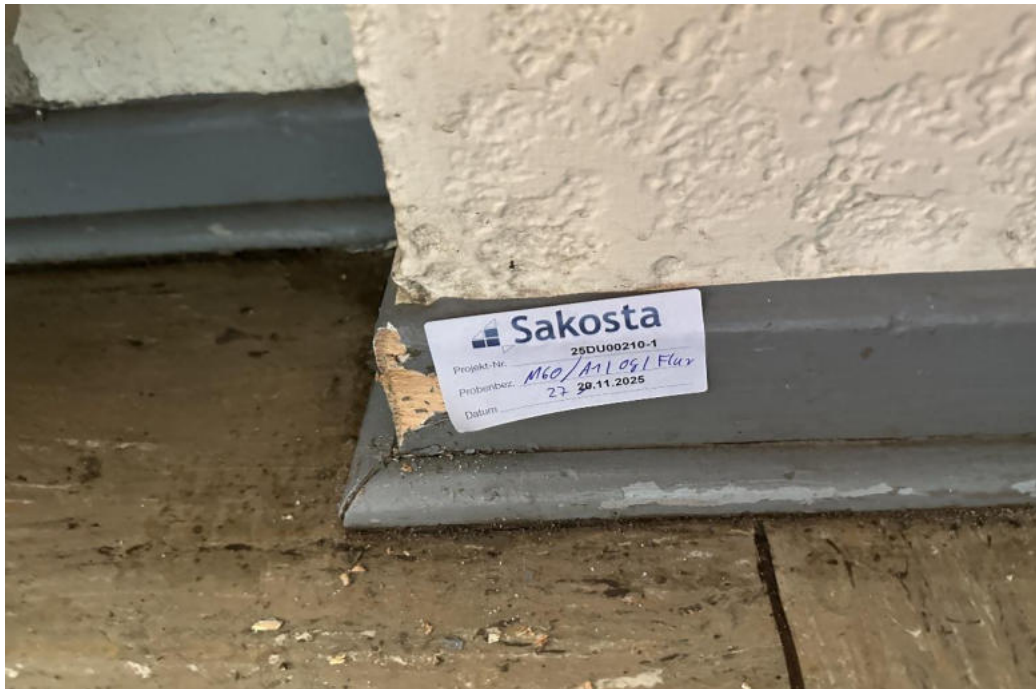
Bild 9: Anstriche von Fußleisten in unterschiedlichen Farben in Erdgeschoss und 1.Obergeschoss (hellblau, dunkelbraun, blau-grün) sind PCB-belastet. Gemäß den Proben: M60/A1/OG/Flur, M20/A1/EG/A1 sowie den früheren Schadstoffuntersuchungsberichten (WESSLING GmbH, 05/2013). Hinweis: Die hellblaue Fußleiste ist zusätzlich asbesthaltig (Probe M60/A1/OG/Flur).
